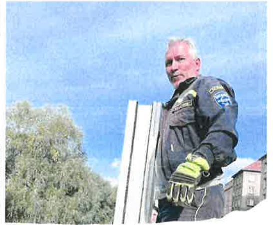
Stavba protipovodňové stěny
