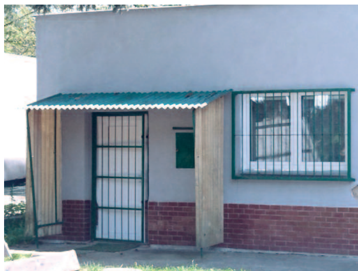
Nové plastové dveře a okna, požární zbrojnice v Mojžíři
