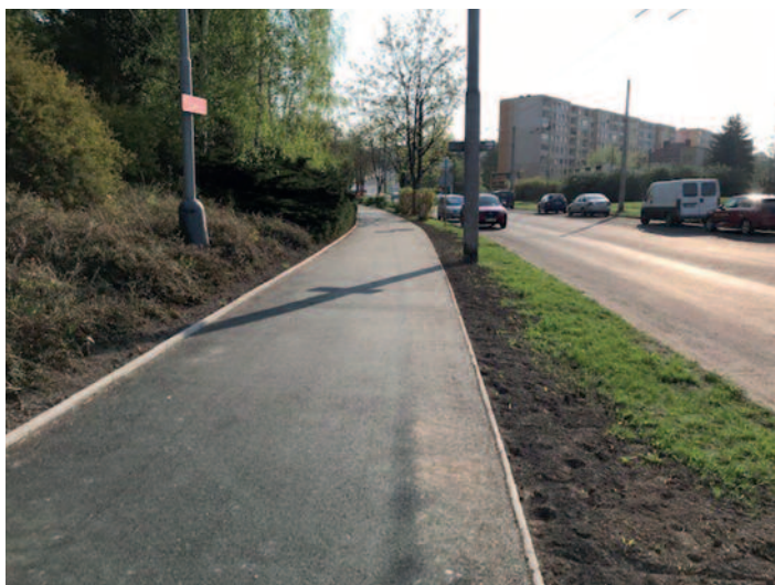
Neštětická, po opravě
