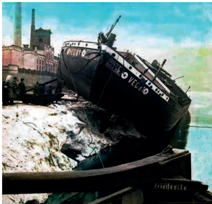
Oprava labského člunu v Neštěmicích v roce 1920 na snímku R. Jenatschkeho
