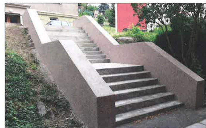
Sibiřská ulice, opravené schodiště
