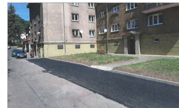
Sibiřská ulice, oprava výmolů před travnatou plochou
