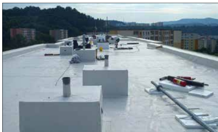
Nová střecha v ulici A. České.
