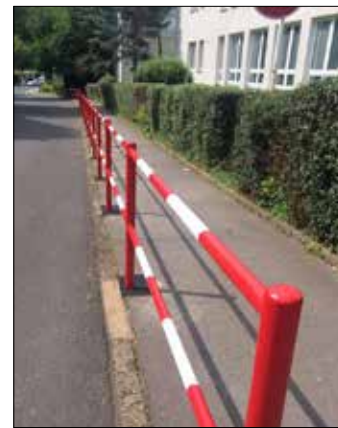
Zábradlí před ZŠ v Hluboké ulici.
