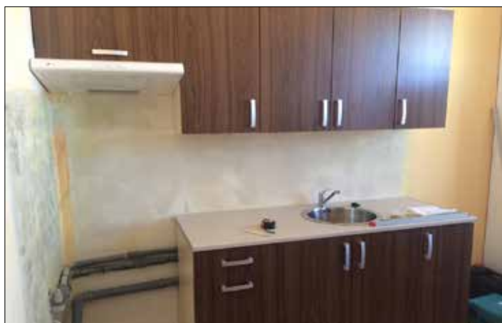
Výměna kuchyňské linky – sídliště Na Vyhlídce.
